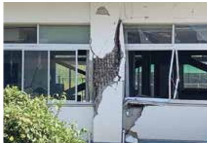
同阿蘇キャンパス 1階柱せん断破壊状況
