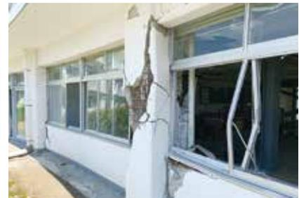
同阿蘇キャンパス 1階せん断破壊状況
