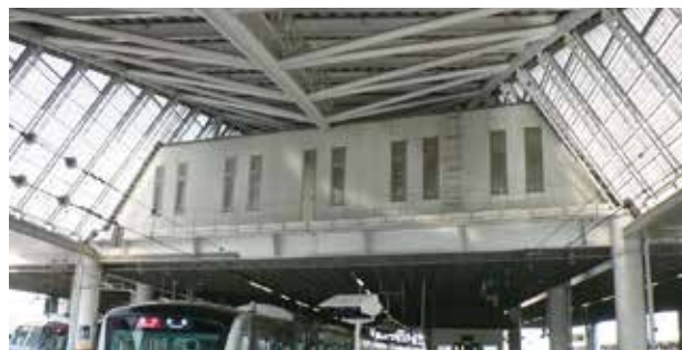
小田原駅自由通路売店裏からのキールトラス
