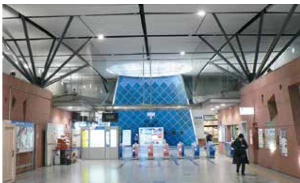
秦野駅屋根支持方杖とコンコーストップライト
