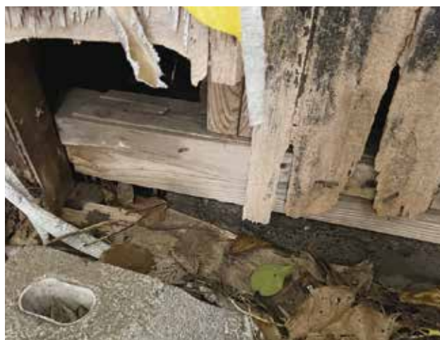
腐朽した各部材
